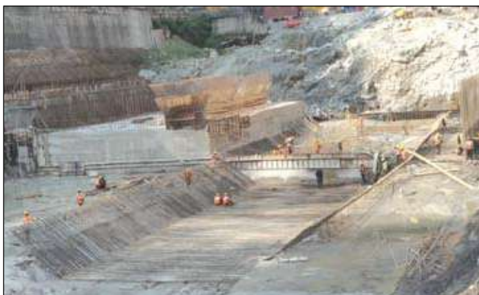
Barrage Constuction - Teesta VI H.E. Project
